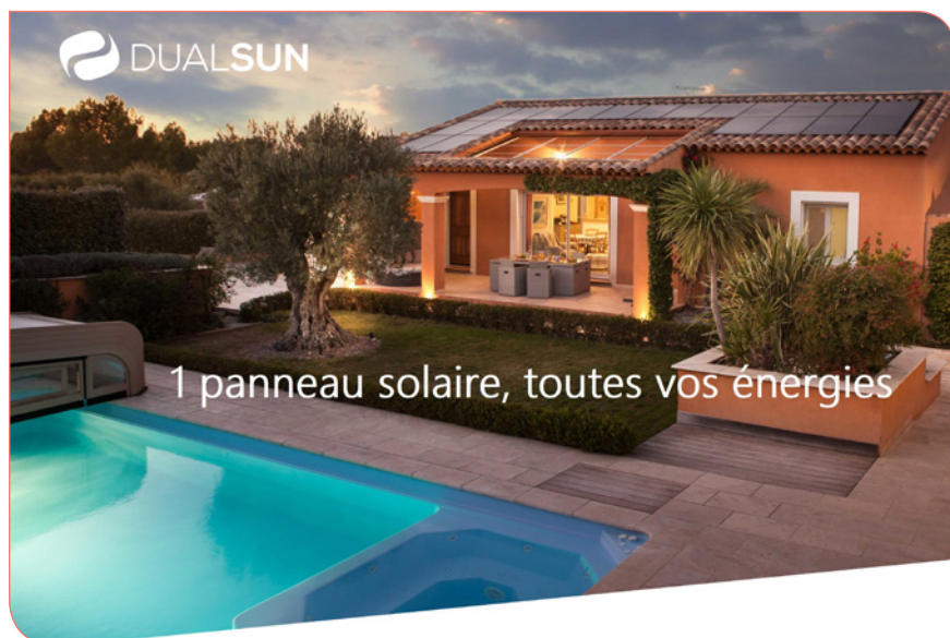
Installation DualSun à Alleins (13) ©DualSun
