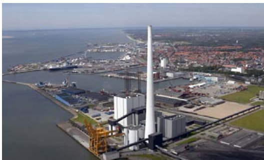
L'usine pilote du projet européen Castor de captage/stockage du CO 2 (Danemark). Photo IFP.
