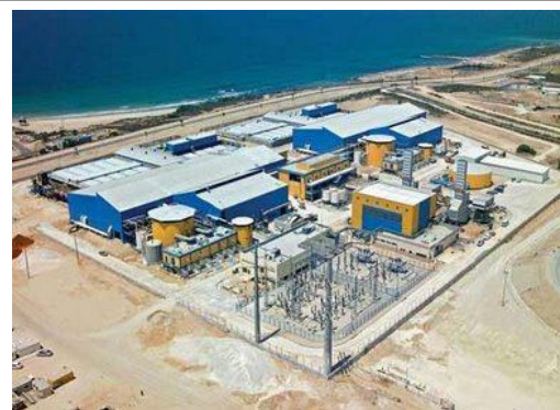
Usine de dessalement d'Ashkelon
